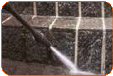
Limpeza de pátios, calçados e terraços
